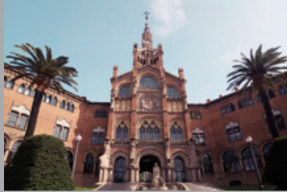
Nou Hospital de La Santa Creu I Sant Pau Barcelona, SPAIN
